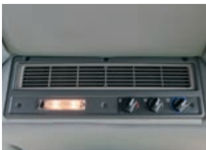
Klimaanlage und Heizung verfügbar
